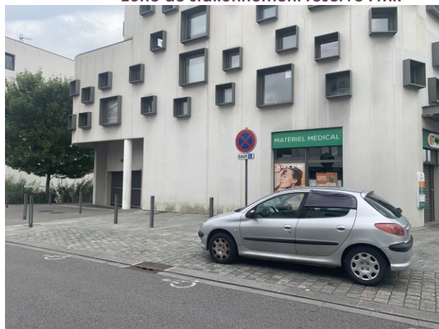
Zone de stationnement réservé PMR
